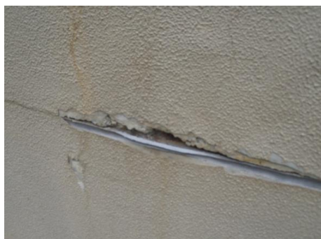
(シーリングの劣化)
