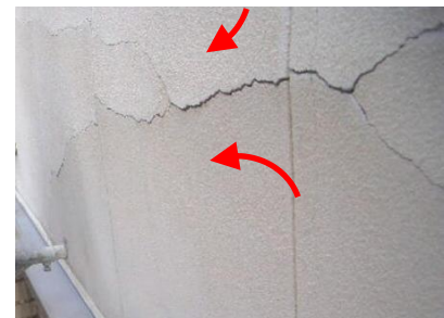
（表面の浮きあがり）
