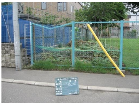
(除雪による破損 - 1)
