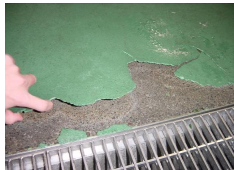
(剥離して、隙間がある)
