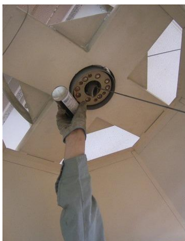
固定部分点検清掃
