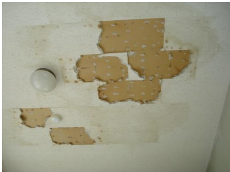
(雨漏りによる天井材剥落)
