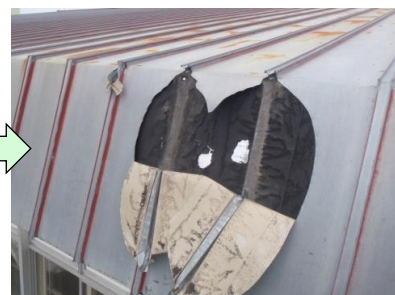
（板金のめくれ）
