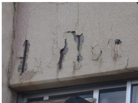
(コンクリートの爆裂)
