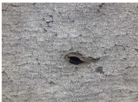
(経年劣化による穴あき)
