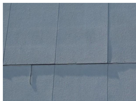
(サイディングの浮き)
