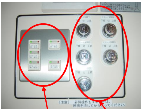
照明用スイッチ
