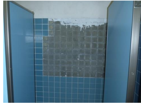
（タイルの剥落）
