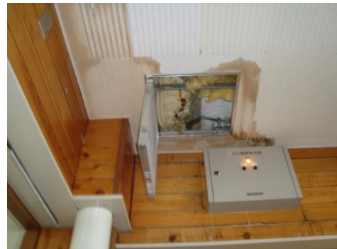
(制御盤付近の雨漏り)
