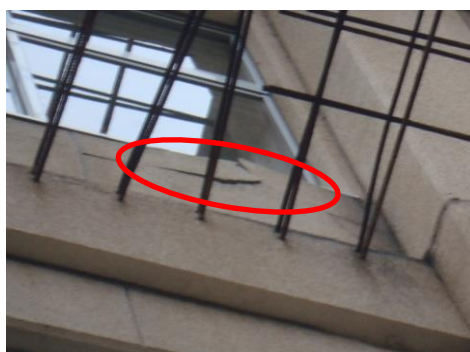
（モルタル剥落直前）
