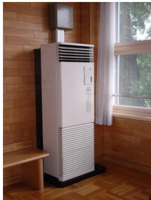
FF式温風暖房機（縦型） (主に特別教室に設置)
