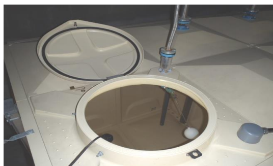
(点検用マンホール)
