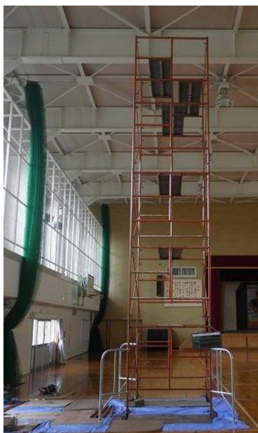
足場組立 (ローリングタワー)
