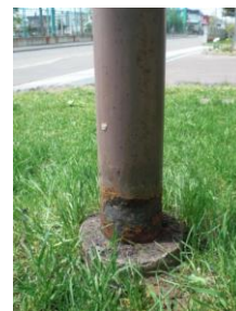
(ポールの腐食状況)
