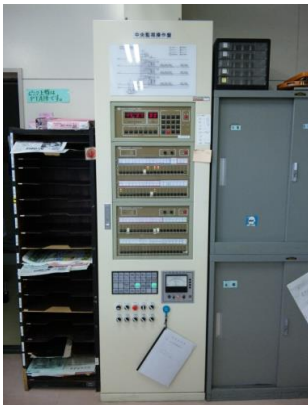
集中監視制御 (職員室内に設置)
