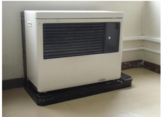
FF式温風暖房機（横型） (主に普通教室に設置)
