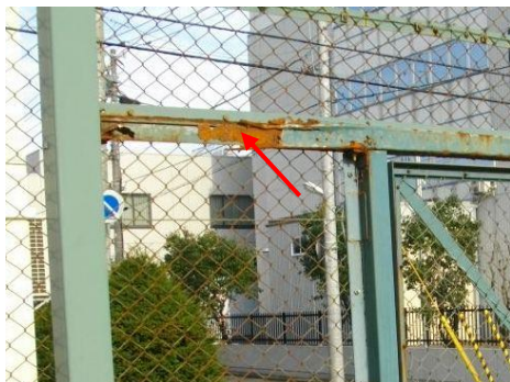
(錆による腐食)
