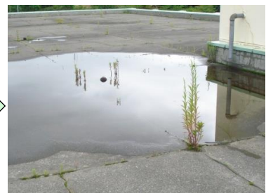
(水溜り、漏水の状態)
