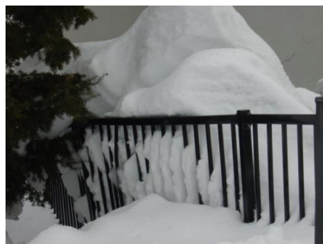
(除雪による破損 - 2)
