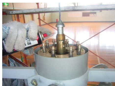
可動部分点検清掃
