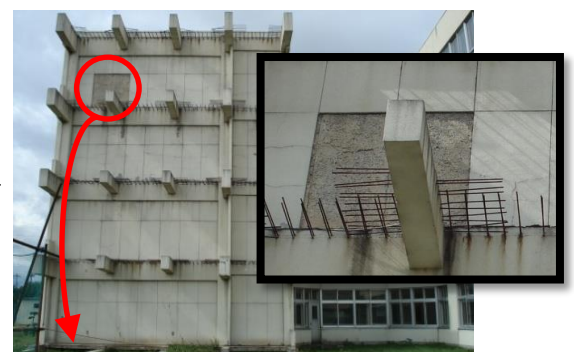
（モルタル剥落後）
