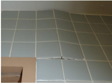
（タイルの浮き）
