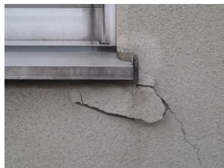
(壁の欠損・クラック)
