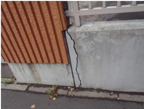
(コンクリート塀の亀裂)
